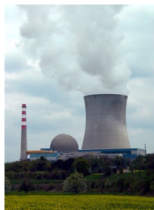
Kernkraftwerk Leibstadt, Aargau © EDA, Präsenz Schweiz
