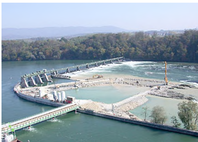
Neubauprojekt Wasserkraftwerk Rheinfelden
