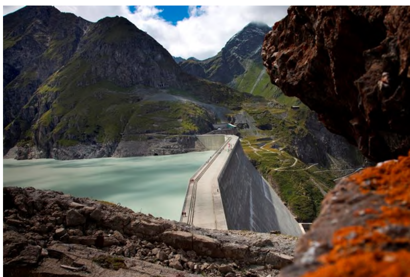
Staumauer Grande Dixence © EDA, Präsenz Schweiz
