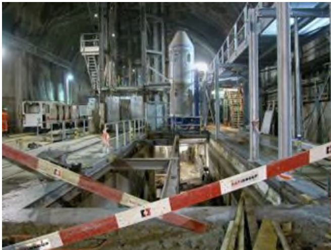
Die NEAT-Baustelle © EDA, Präsenz Schweiz
