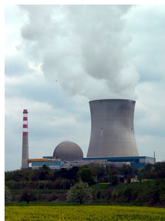
Kernkraftwerk Leibstadt, Aargau © EDA, Präsenz Schweiz
