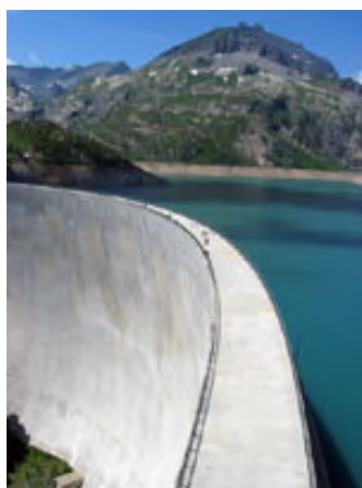
Speicherkraftwerk Emosson, Wallis © EDA, Präsenz Schweiz
